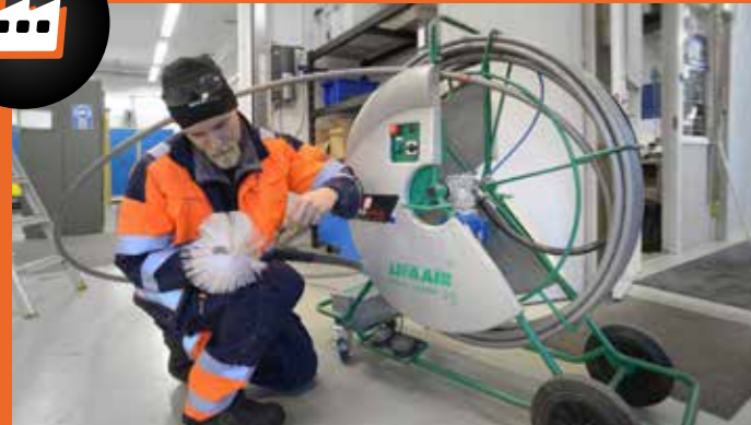
ILMASTOINTIKANAVIEN PUHDISTUKSET JA DESIFIOINNIT Lifa Air IV kanavien puhdistuslaitteella ja alipaineistajalla
