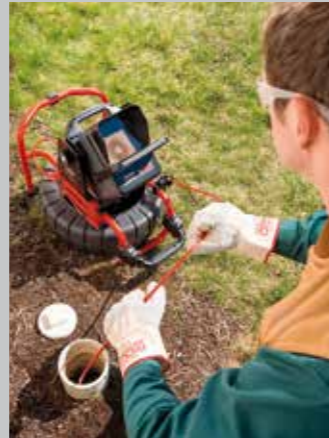
VIEMÄRIEN PAIKANNUKSET JA KUVAUKSET Ridgrid viemärikameralla ja paikannuslaitteella
