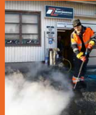
JÄÄNSULATUS PALVELUT (viemäreiden ja rumpuputkien sulatukseen) HotBox höyrykehittimellä 21 l/min-300bar
